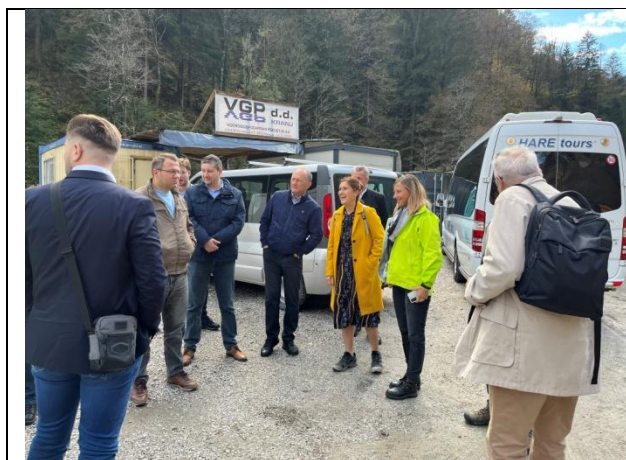
Gradbišče zadrževalnika Zali log; Foto: Yunus Oruc
